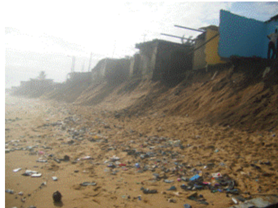
Figure 9 : Érosion côtière et destruction à Port-Bouet
