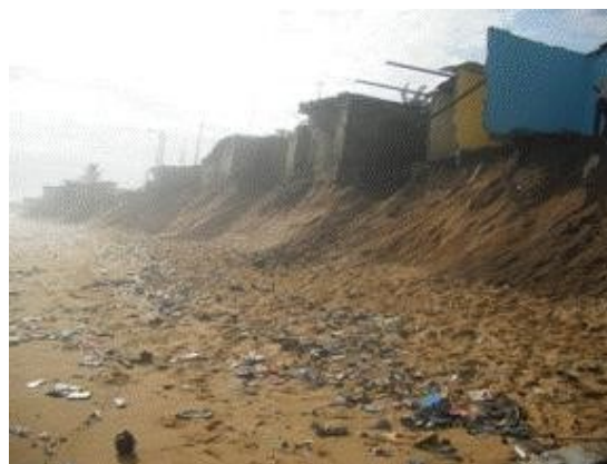
Figure 8: Érosion côtière et destruction à
